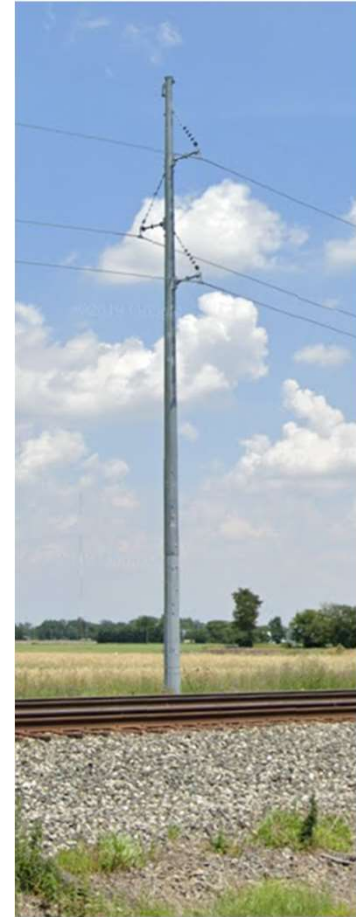
69kV Single-Circuit Monopole Structure
